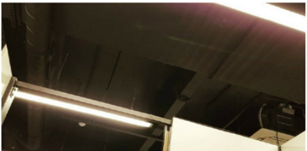
После полировки. Полностью восстановлена прозрачность стекла.
